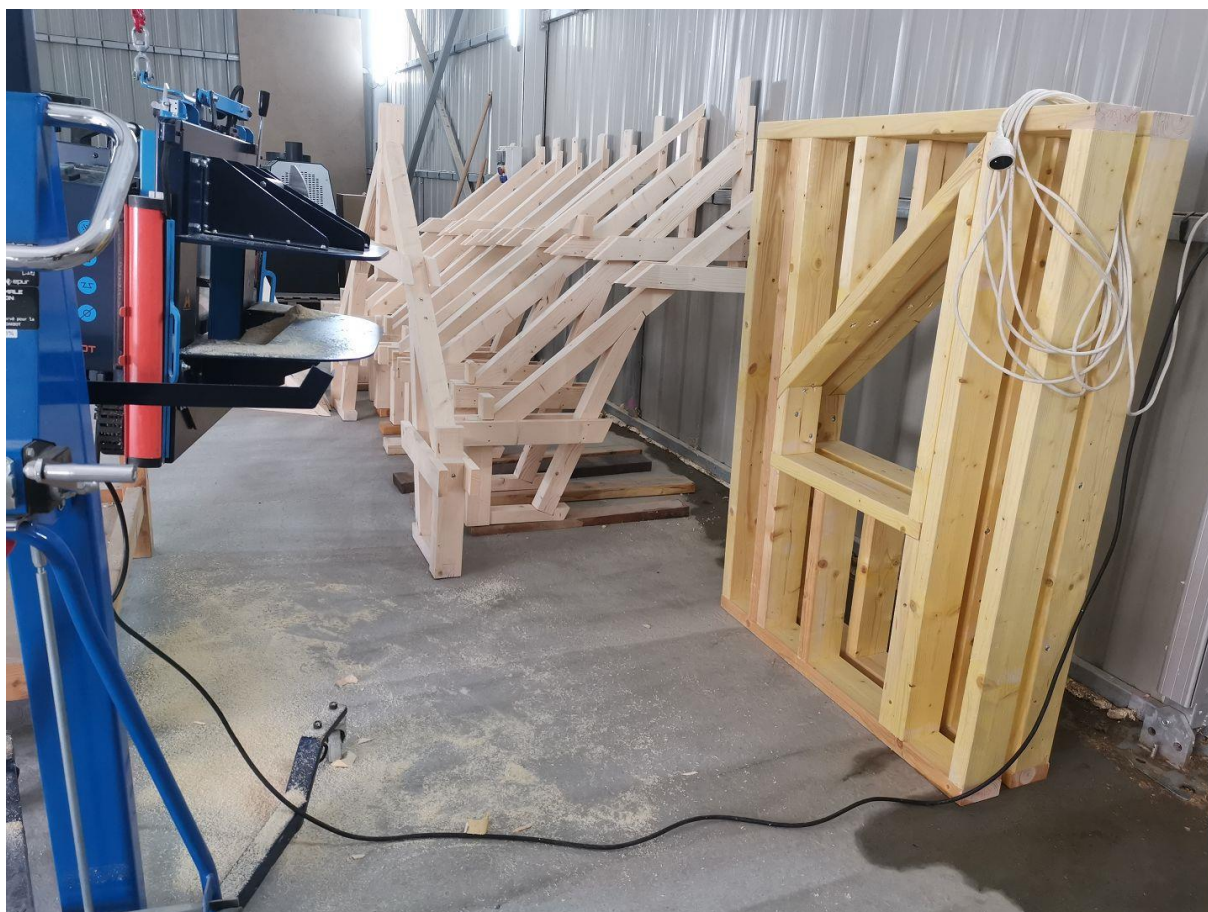
Figure 8 - Vue de l'atelier CoBo (Construction Bois) sous le "Chapiteau" avec commande numérique et demi-fermes réalisées par les apprenants
